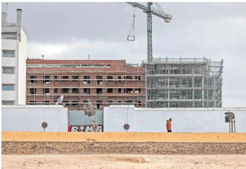
Construcción de Viviendas de Protección Oficial en Cádiz. PACO PUNTES
